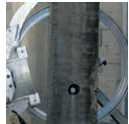
Profondeur exceptionnelle de coupe jusqu'à 400 mm
